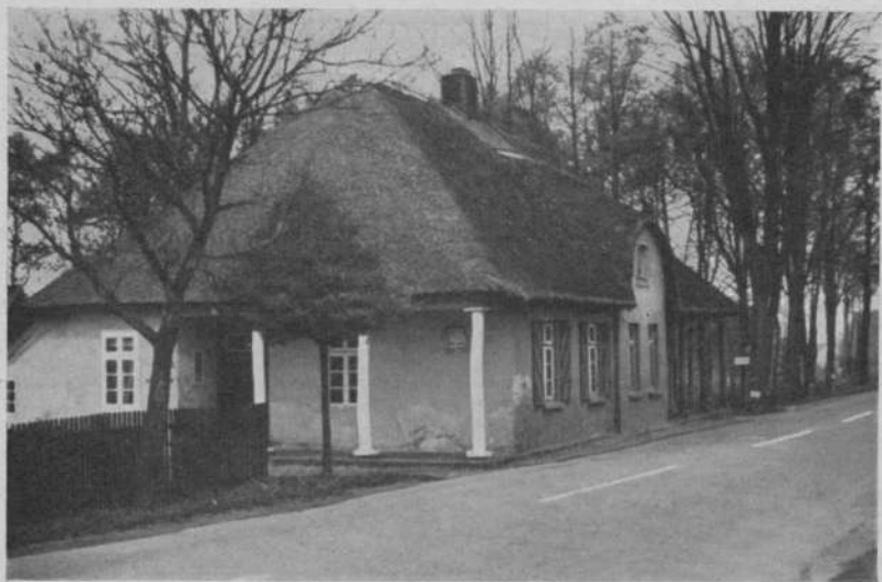
Bild 2: Weghaus Am Wellenberg, Bundesstraße 4, Uelzen — Lüneburg.
