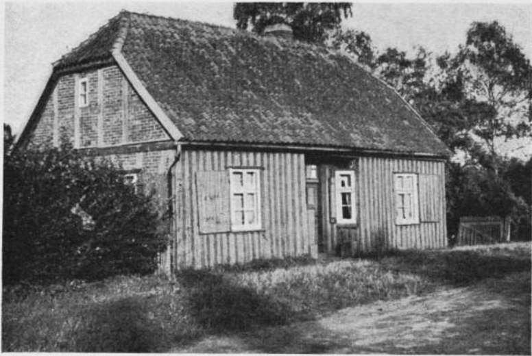
Bild 3: Weghaus Klein Eicklingen, Bundesstraße 214, Celle — Braunschweig.
